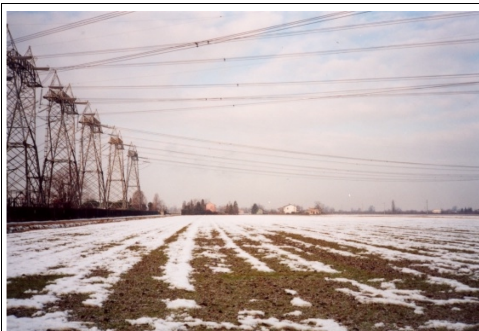
Fig. 1 -Sito d'interesse fotografato dal vertice Nord-orientale. Particolare dei tralicci della sottostazione ENEL
